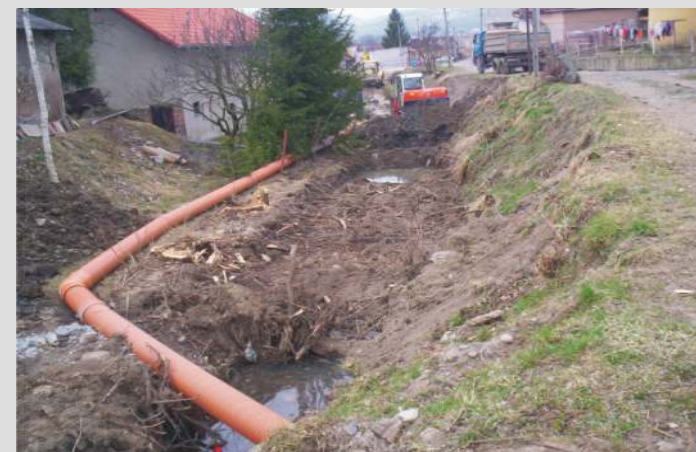
Úprava toku nad cestným mostom
