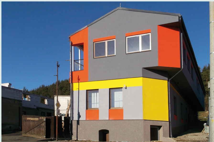
Zrekonštruovaná materská škola
